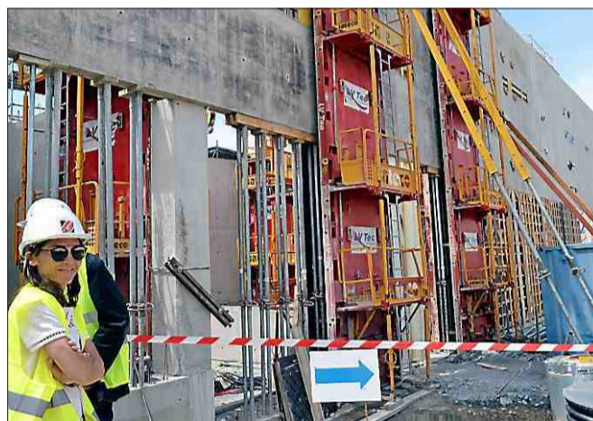
■ Agnès Jullian devant les futurs quais de chargement.
