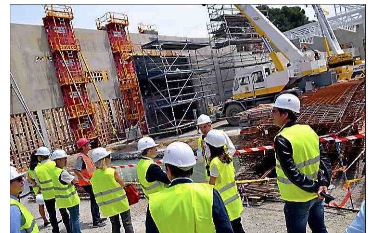
■ À l'intérieur du futur site d'assemblage et de stockage.
