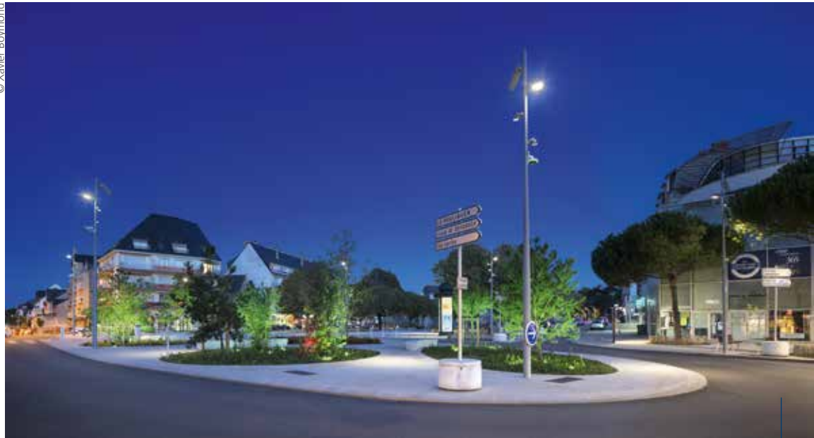
La place de la Victoire se distingue par un espace ovoïde, ponctué d'îlots végétalisés. Chaque arbre est mis en lumière par des projecteurs encastrés de 20 W.
