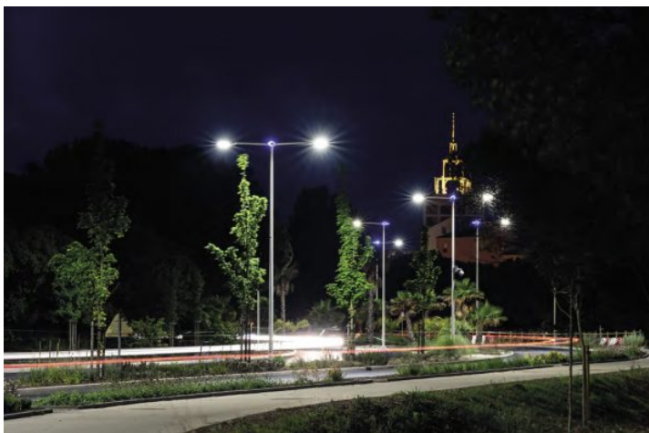
Cap d'Agde. Mâts Valmont. Installateur : Allez et Cie © Valmont. Photo Lotfi Dakhli
