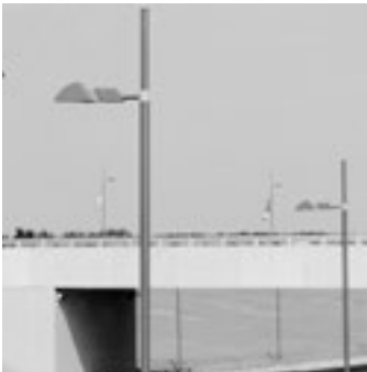
Montpellier Entrée Est - Av. Pierre Mendes France 1992
